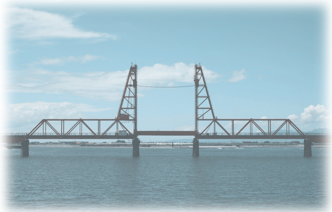
筑後川昇開橋
