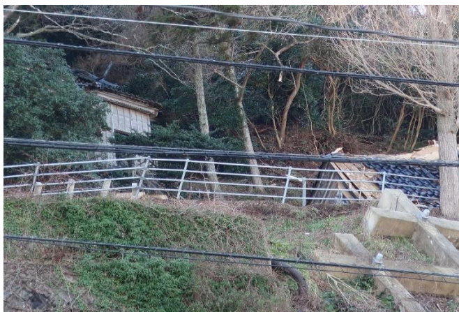
倒壊した拝殿（写真右建物）
